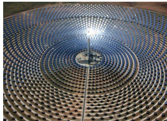
La centrale solaire Noor Ouarzazate III
